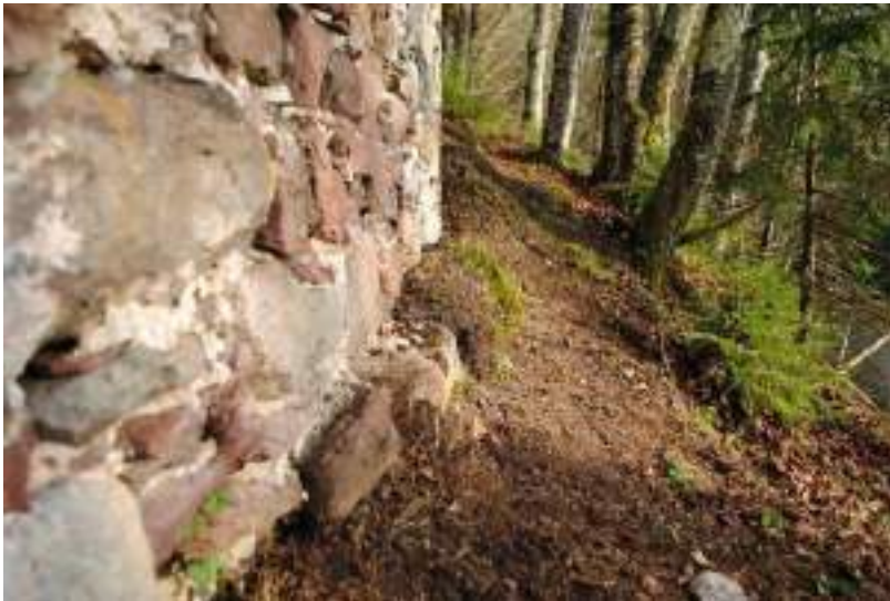
Slika 6.35: Okrepljen temelj jugozahodnega obodnega zidu grajskega jedra (zid 15), pogled proti vzhodu (foto: T. Jerina; 22. 11. 2014, Nikon D3000, DSC_0116).
