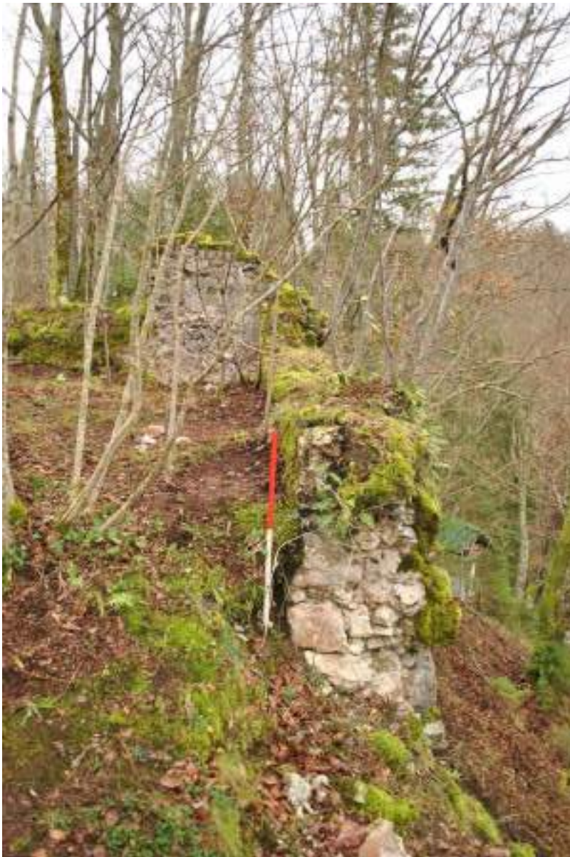
Slika 6.17: Presek skozi jugozahodni obodni zid grajskega jedra (zid 1), pogled proti jugovzhodu (foto: B. Bovcon; 24. 11. 2014, Nikon D3000, DSC_3297).
