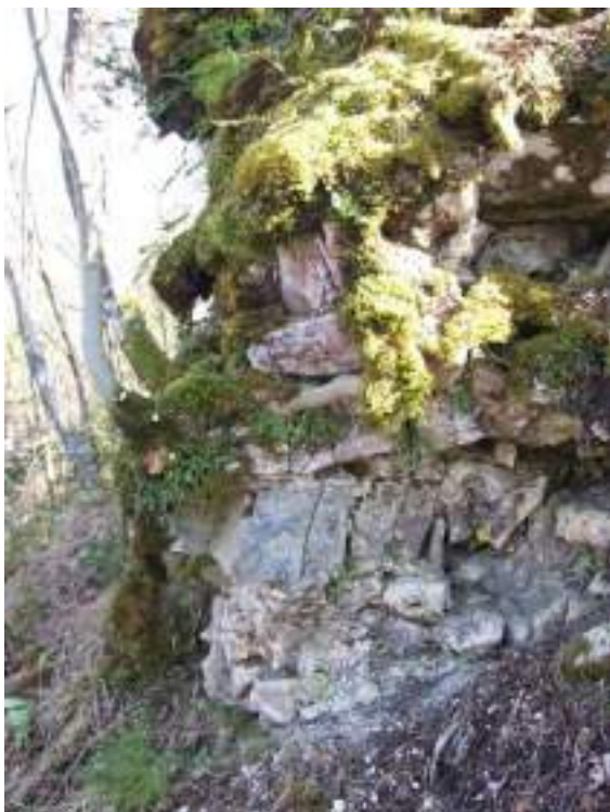
Slika 14. V temelju vogala med zidoma 2 in 3 so zgradeni dolomitni gradniki litotipa Ed in B.
