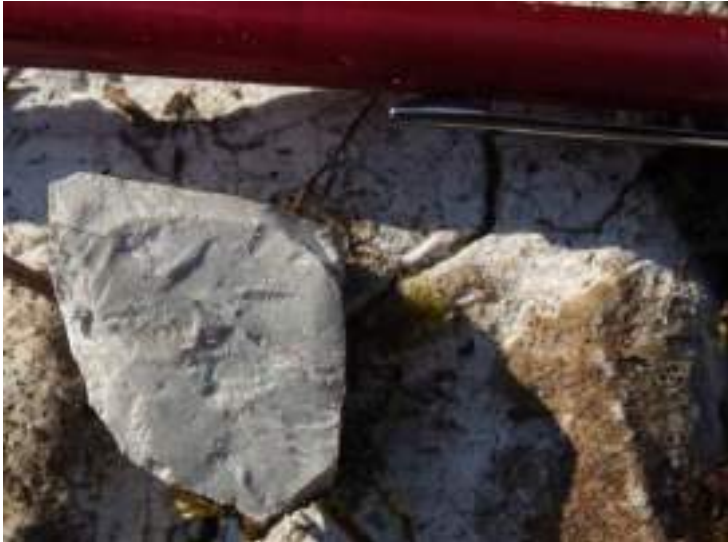
Slika 21. Gradnik iz belega dolomitnega apnenca - litotip C iz zidu 8.
