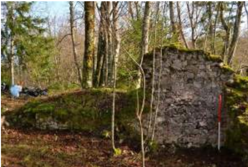
Slika 6.26: Jugovzhodni zid osrednje grajske stavbe (zid 4), notranje lice v vogalu z zidom 1. Vidni so sledovi ometa. Pogled proti jugovzhodu (foto: B. Bovcon; 22. 11. 2014, Nikon D3100, DSC_8892).
