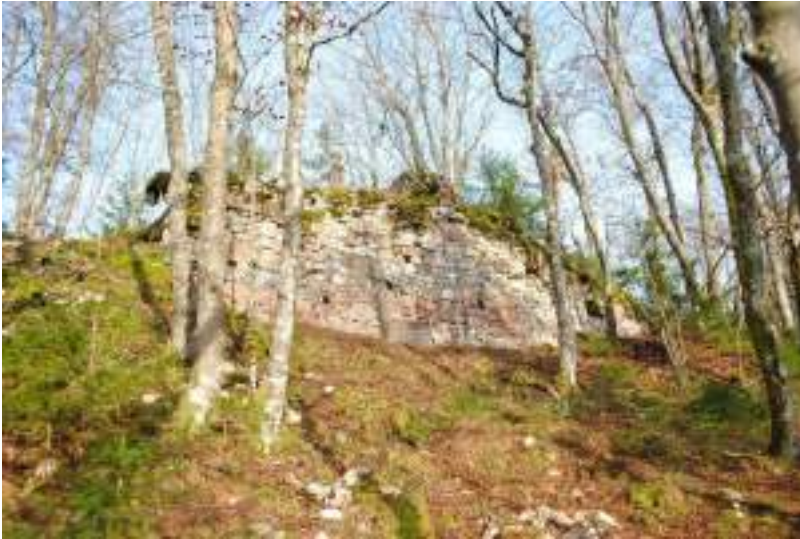
Slika 6.16: Vzhodni del jugozahodnega obodnega zidu grajskega jedra (zid 1). Zunanja stran, pogled proti severovzhodu (foto: T. Jerina; 22. 11. 2014, Nikon D3000, DSC_0109).
