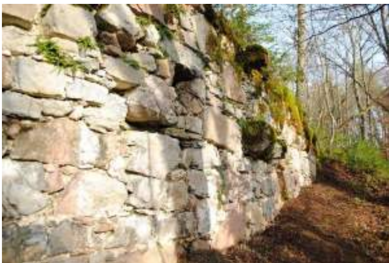
Slika 6.28: Južni obodni zid grajskega jedra (zid 5), pogled proti severovzhodu (foto: T. Jerina; 22. 11. 2014, Nikon D3000, DSC_0117).
