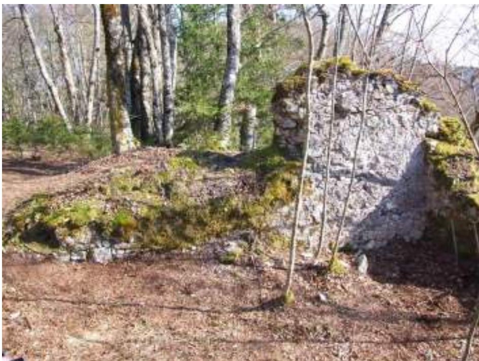
Slika 18. Severni del zidu 4.
