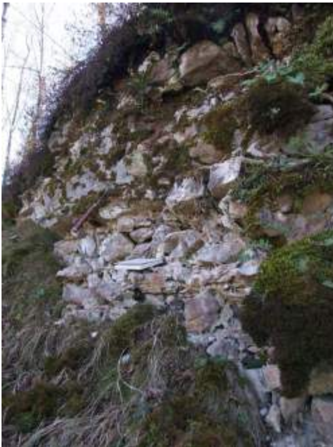
Slika 7. Velika večina rdečkasto obarvanih gradnikov v spodnjem delu zidu 3 pripada belemu zrnatem dolomitu litotipa B. Rdečo barvo na površini dajejo lišaji.
