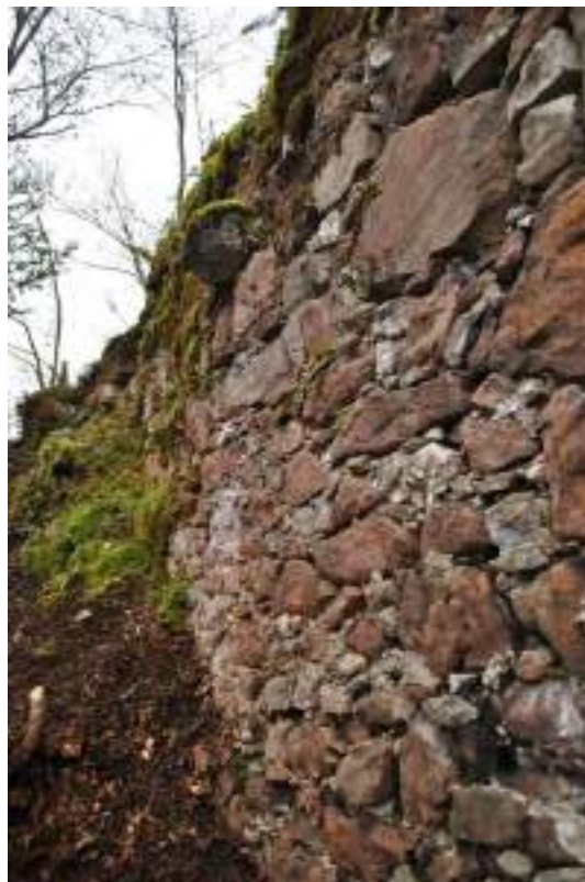
Slika 6.20: Konzola v severozahodnem obodnem zidu grajskega jedra (zid 2). Zunanja stran, pogled proti severu (foto: B. Bovcon; 24. 11. 2014, Nikon D3000, DSC_3349).
