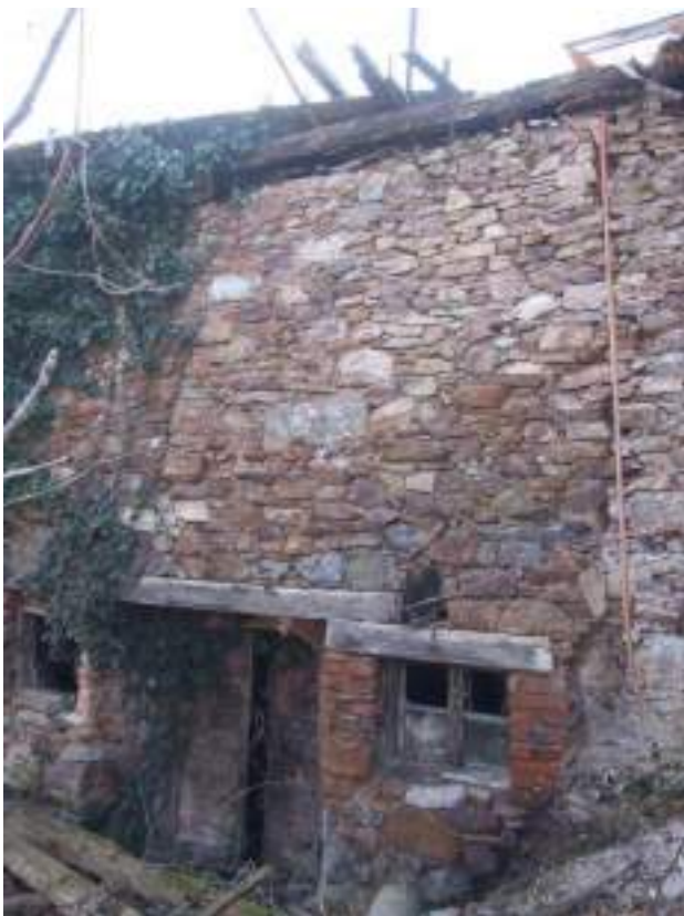
Slika 28. Manjši gradniki rdečega peščenjaka - Litotip A (in litotipov E) v objektu v Malem Ločniku.
