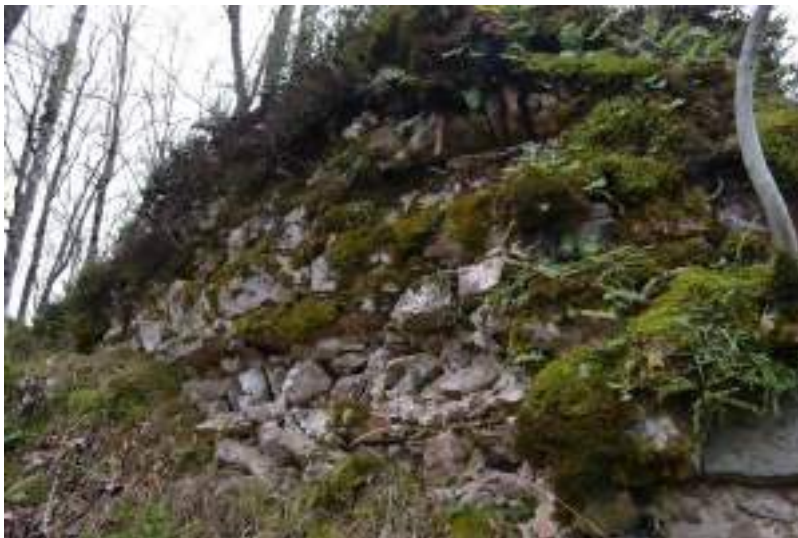
Slika 6.23: Skrajni zahodni del severovzhodnega obodnega zidu grajskega jedra (zid 3). Zunanja stran, pogled proti jugu (foto: K. Predovnik; 22. 12. 2014, Nikon D3100, DSC_9368).
