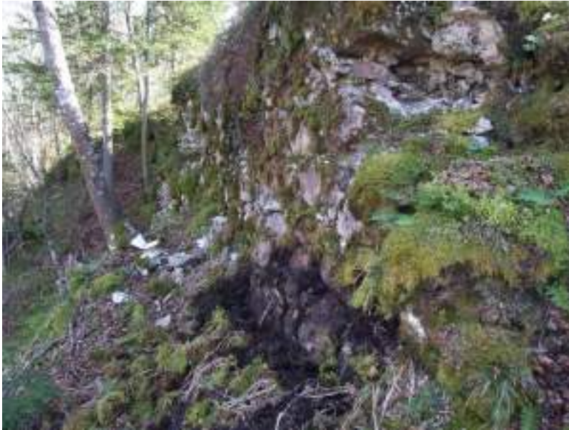
Slika 6.22: Vzvodni del severovzhodnega obodnega zidu grajskega jedra (zid 3), pogled proti jugovzhodu. Vidno je zunanje lice z gradniki iz rdečega peščenjaka. S krajšega odseka temelja je bil odstranjen mah, kar se je zgodilo po tem, ko je naša ekipa s terenskim delom že zaključila. Mi zidov nismo čistili (foto: I. Rižnar; 10. 3. 2015).
