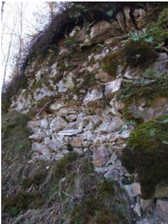
Slika 15. Vzhodni del zidu 3 je zgrajen v glavnem iz litotipa A
