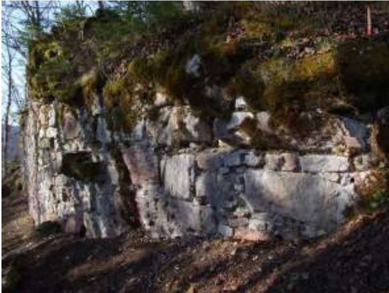
Slika 19. Veliki klesani bloki litotipa A v zidu 5.
