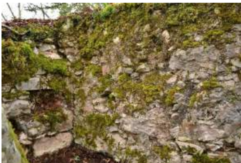
Slika 6.27: Vzhodni notranji vogal osrednje grajske stavbe. Lepo je vidno, da se zid 4 (desno) naslanja na zid 3 (levo). Pogled proti vzhodu (foto: N. Jamnik; 24. 11. 2014, Nikon D3100, DSC_9362).
